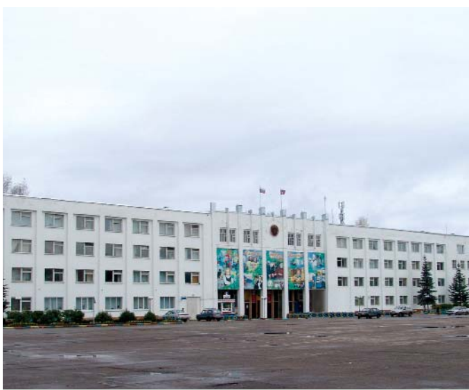
Здание городской администрации г. Мирного
