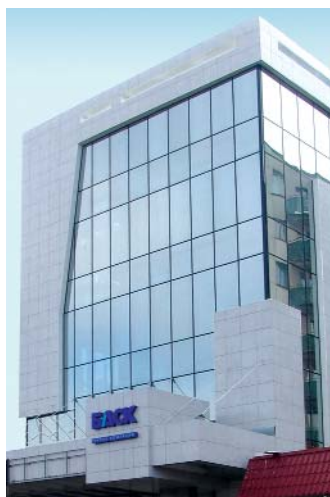
Здание защищено охранной системой, разработанной и установленной специалистами Белгородского филиала ОАО ЦНПО «Каскад»
