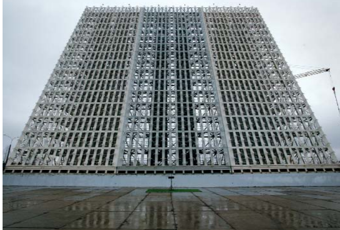
РЛС типа «Воронеж», на которой ведутся работы силами филиала
