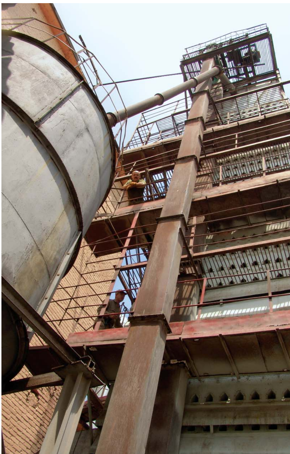
Монтажники Г.Н. Щербина и А.А. Алексеевский ведут высотные работы на одном из гражданских объектов филиала
