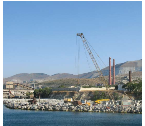
Пирс на стадии строительства. Вид с моря на мыс Шиссарис
