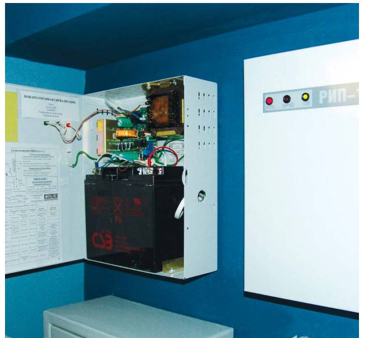
Резервный источник питания аппаратуры ОПС РИП-12 группового питания извещателей и приемно-контрольных приборов охранной и охранно-пожарной сигнализации рассчитан на непрерывный круглосуточный режим работы с заданными выходными параметрами, с автоматическим подзарядом встроенной герметичной аккумуляторной батареи
