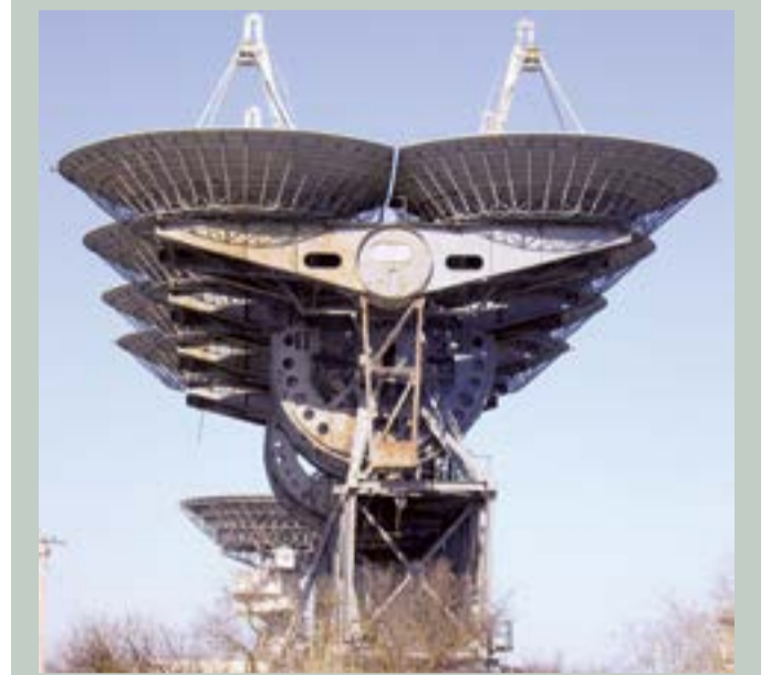
Антенна АДУ-1000 работает в дециметровом диапазоне волн ( \lambda = 30-40 см).
