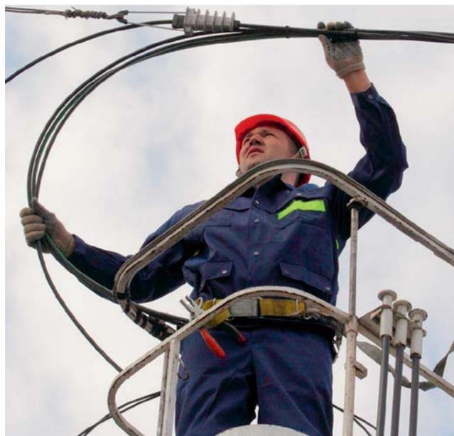
Прокладка ВОЛС по линии высоковольтной электропередачи. Оптоволоконко является диэлектриком, поэтому исключено какое-либо негативное воздействие со стороны проводника. Подобная технология позволяет избежать дорогостоящих земляных работ, особенно в местностях, где они затруднены (горная, каменистая). Широко применяется «КАСКАДОМ», в частности, в Краснодарском крае
