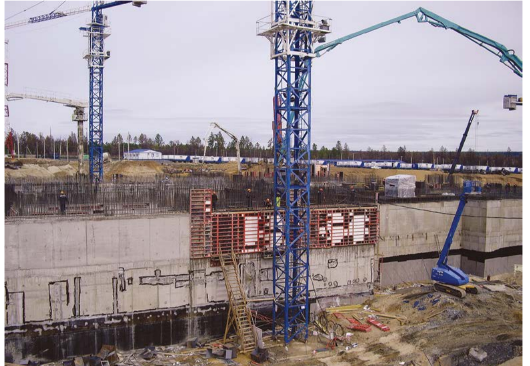
Строительная площадка будущего стартового комплекса
